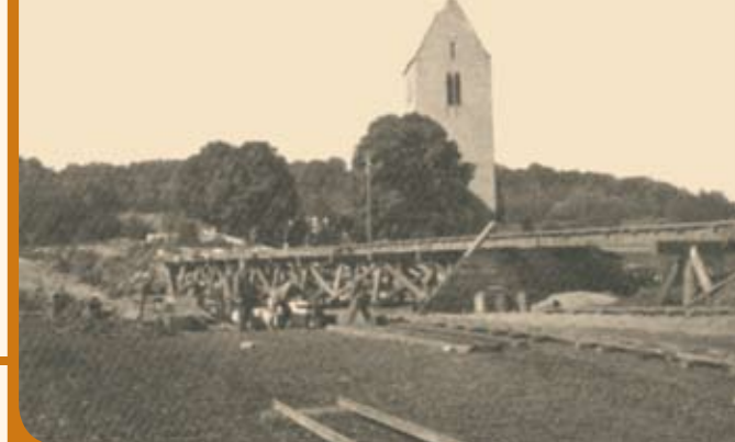
Travaux de chemin de fer à l'automne 1915
